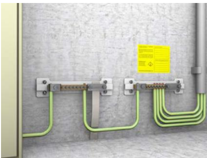
Abb.1 Anschluss des Potentialausgleichsleiters an Potentialausgleichsschiene mit Kennzeichnung.
