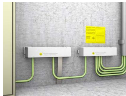
Abb.2 Abgeschlossene Erdung der Fasadensflächen mit Kennzeichnungen.
