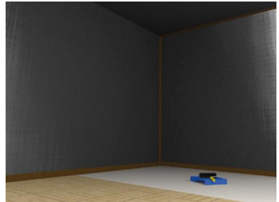
Abb.8 Streichen der grossen Flächen mit HF65FT. Nach der Erdung der Schirmfläche an den vorgesehenen Erdungspunkten kann die Abschirmfarbe mit Deckfarbe überstrichen und übertapeziert werden (Rolle mit Flor 10-12 mm).
