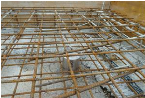
Platzierung eines NIP-Zylinders im Neubau.
