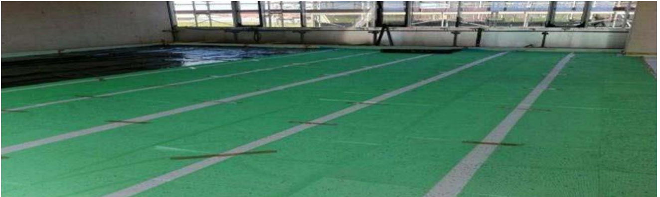
NIP-Netz auf der Trittschalldämmung unter dem Bodenbelag fixiert.
