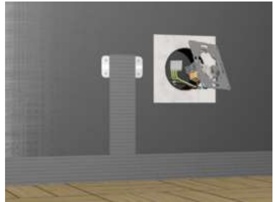
Abb.2 Erdungsplatte neben Steckdose / Führung des Erdungsbandes / Einführen des Erdungsdrahtes in die Wanddose.
