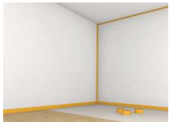
Abb.4 Aufkleben des elektrisch leitfähigen Erdungsbandes AEB im Sockelbereich. Soll der Deckenbereich geschirmt werden, wird das Erdungsband nach oben geführt und über die gesamte Deckenbreite verklebt.
