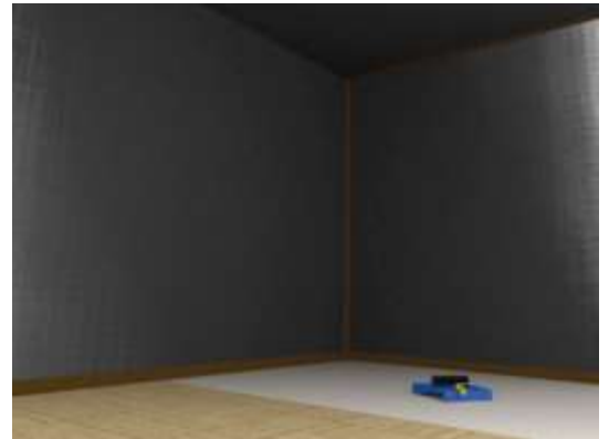
Abb.8 Streichen der grossen Flächen mit HF65FT. Nach der Erdung der Schirmfläche an den vorgesehenen Erdungspunkten kann die Abschirmfarbe mit Deckfarbe überstrichen und übertapeziert werden (Rolle mit Flor 10-12 mm).
